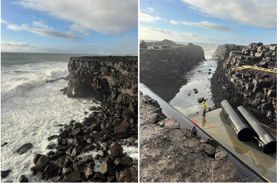
Mynd 1 Frárennsli frá landeldinu verður um stökk sem grafinn hefur verið til sjávar og botn verður steypdur til þess að tryggja að allt vatn renni óhindrað út. Á fyrri mynd má sjá nokkurra metra háan hamravegg og grýtta fjöruna við frárennslisstað. Hin myndin sýnir að unnið er að því að steypa botn og ganga frá frárennsli. Myndir teknar 2. febrúar 2025 (Snorri Gunnarsson).
