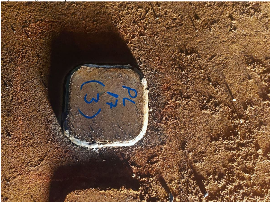
Mynd 10. Viðgerðarbót í plötu 17
