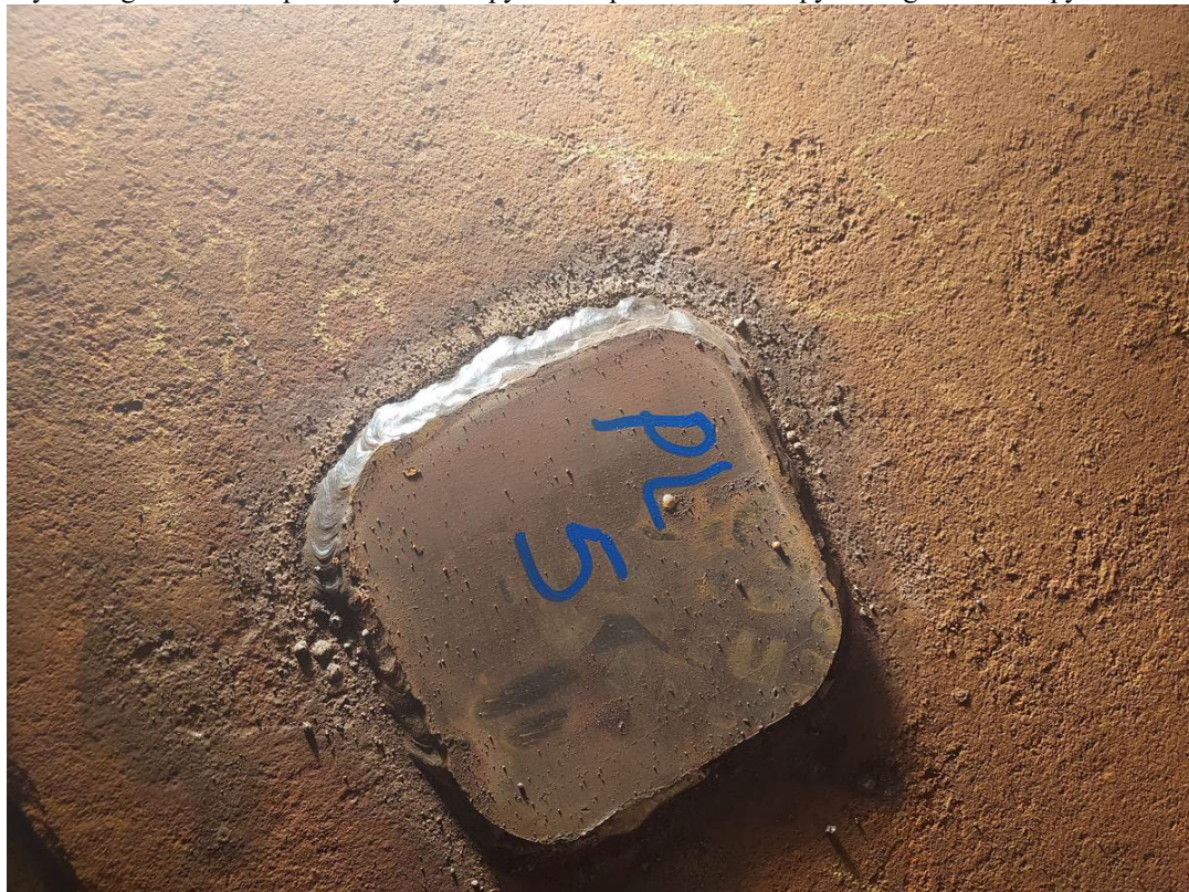
Mynd 7. Viðgerðarbót í plötu 5
