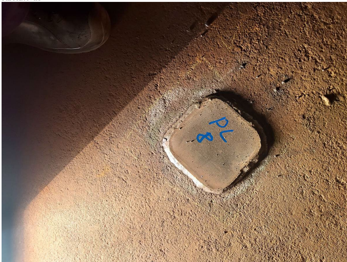
Mynd 13. Viðgerðarbót í plötu 8
