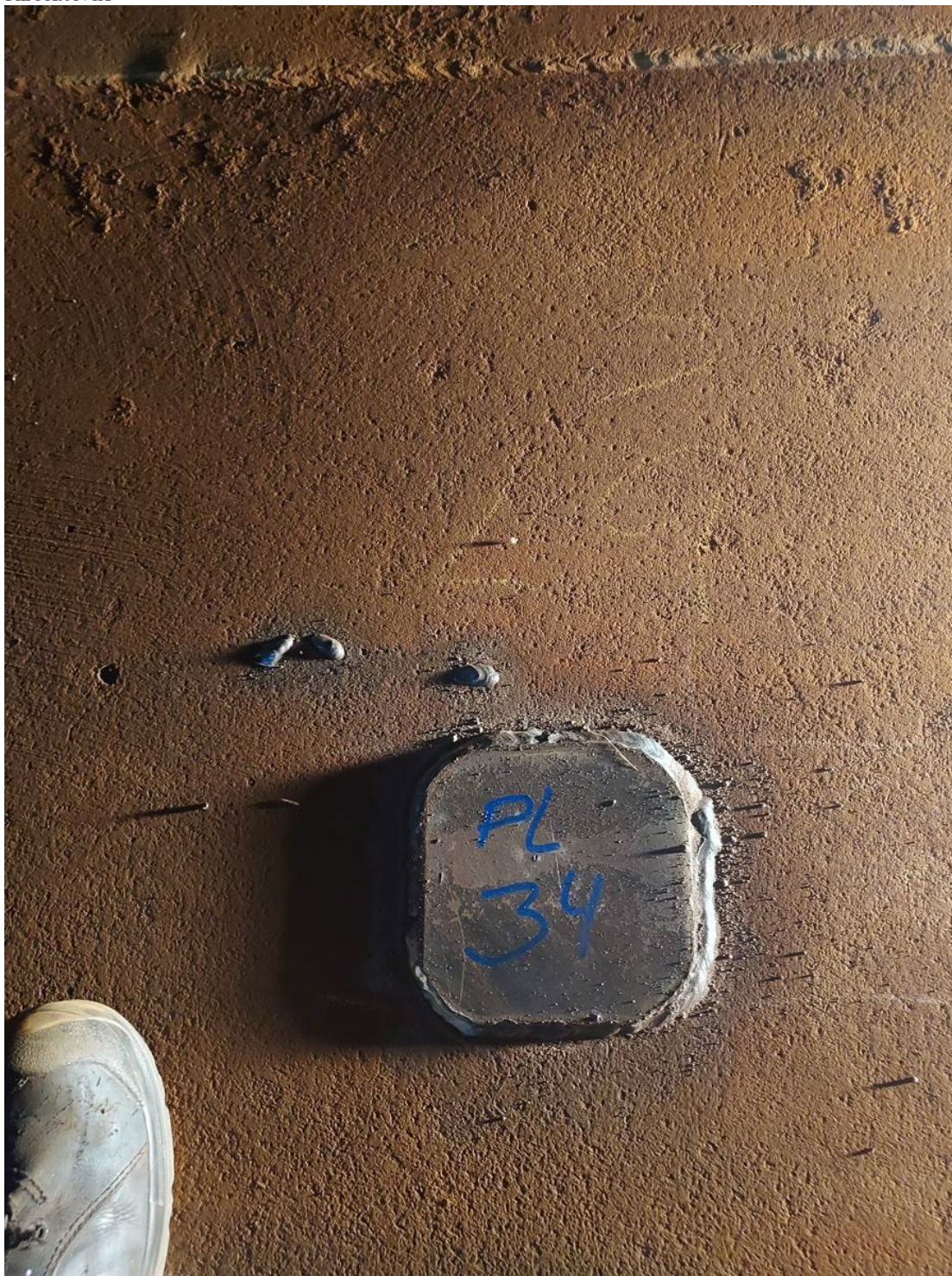
Mynd 8. Viðgerðarbót í plötu 34
