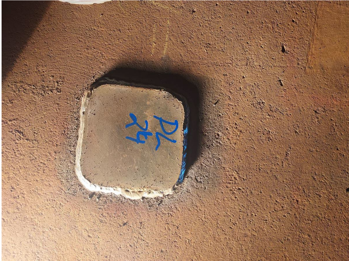
Mynd 9. Viðgerðarbót í plötu 24
