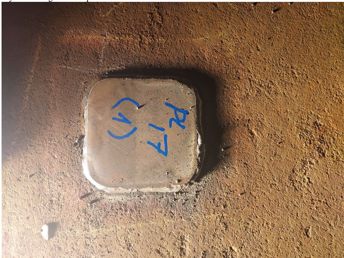
Mynd 12. Viðgerðarbót í plötu 17
