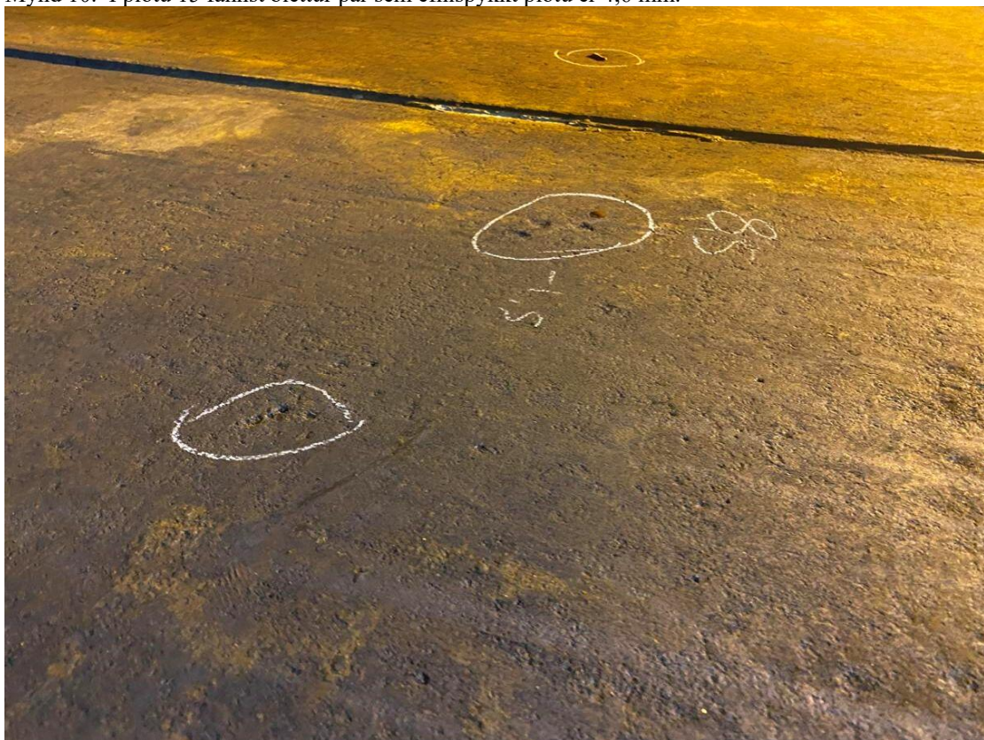
Mynd 11. Víða eru pyttir líkt og sjá má á mynd. Margir merktir með krít.
