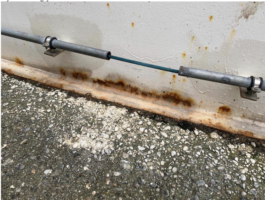
Mynd 13. Málning er farin að láta á sjá utanvert, neðst á geymi.
