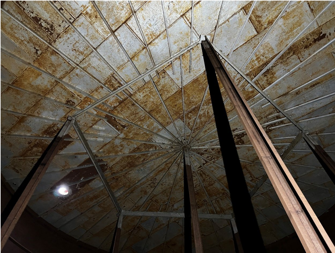
Mynd 1. Þak geymis
