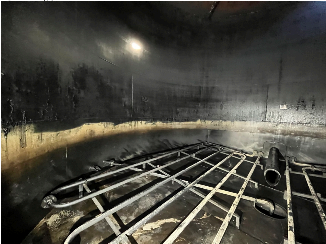
Mynd 2. Gólf og umfar geymis.
