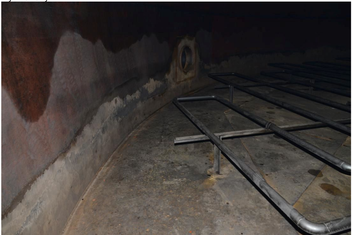
Mynd 4. Ekki fundust nein ummerki tæringar.
