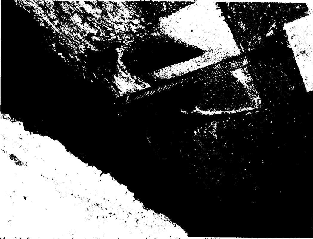
Mynd 1. Þar sem teinar tengjast í geymi vegna gjarðar er töluvert ryð líklega vegna blautrar steinullar.
