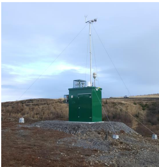
MYND 2 Mælistöð S
