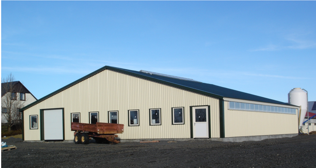
Mynd 7.2: Stálgrindarhús með með fódursíló við gaff, Landstólpi . [16]
