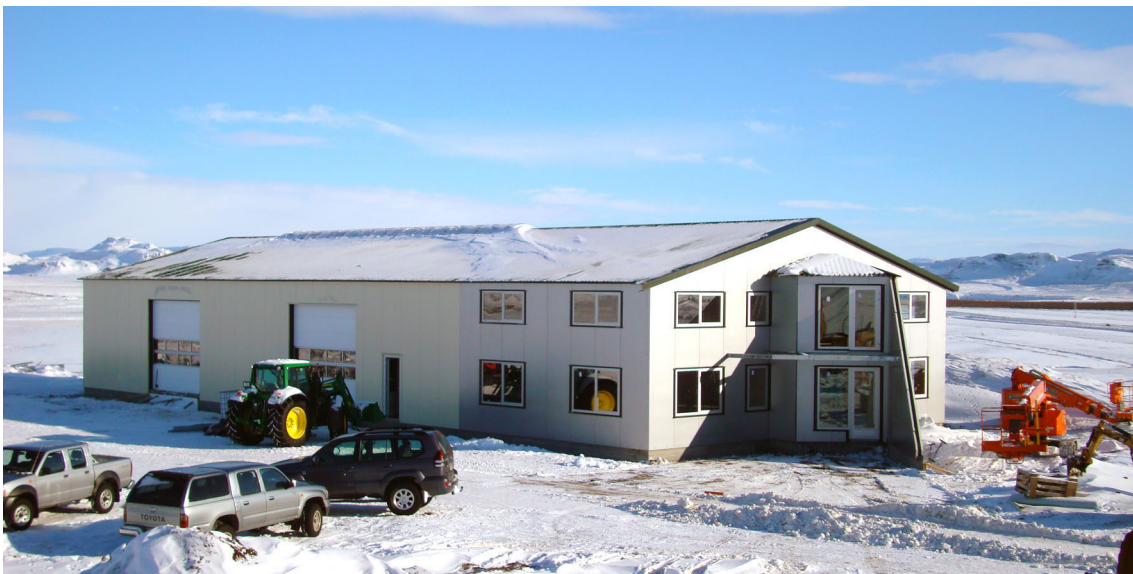
Mynd 7.1: Stálgrindarhús með skrifstofuaðstöðu á tveimur hæðum, Landstólpi . [16]
