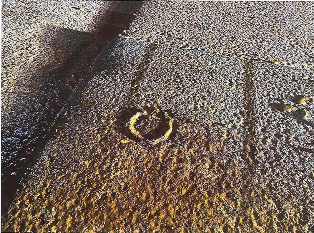
Mynd 4. Víða eru ummerki frá suðu og gólf er alsett grunnnum tæringarpyttum.
