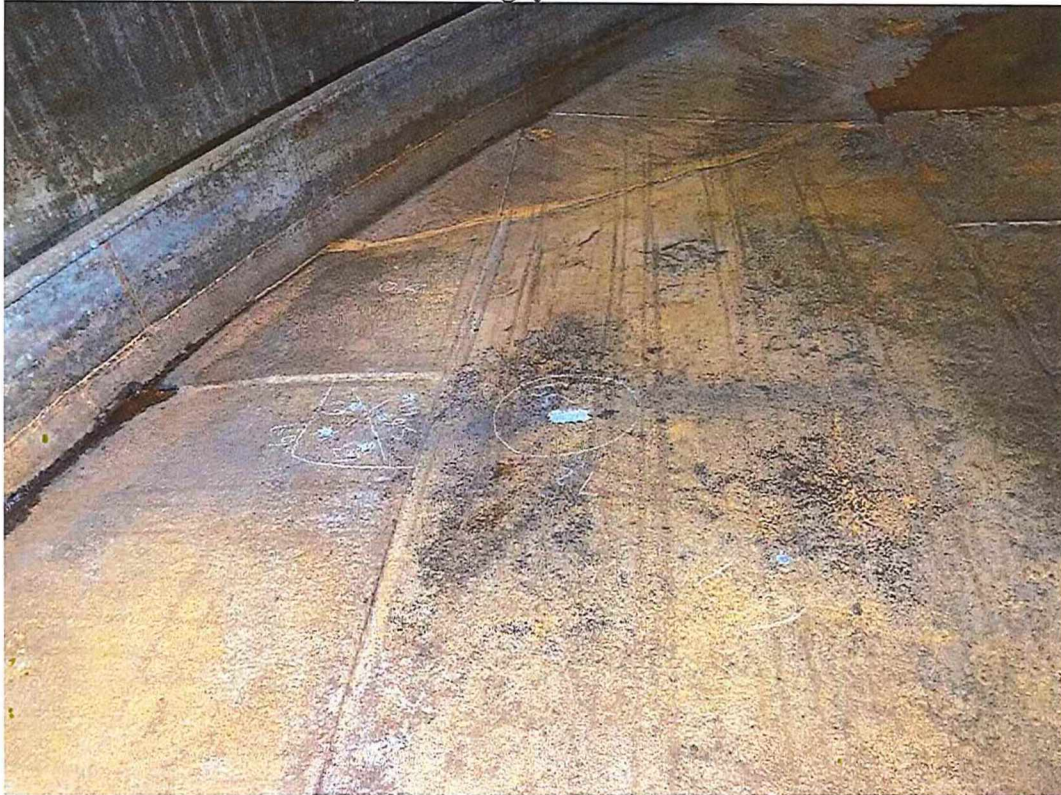
Mynd 1. Geymir er ómálaður að innan. Hér sést hvar tærð svæði hafa verið merkt á plötu.
