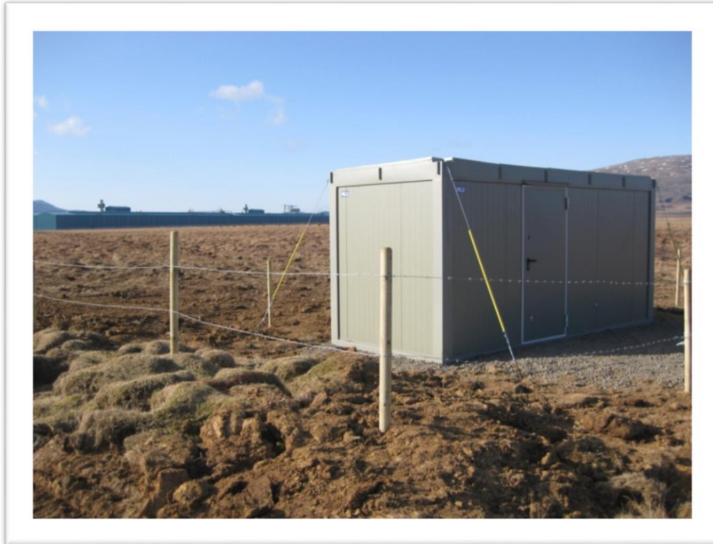
Mynd 1. Loftgæða og veðurmælingahús við Kríuvörðu.
