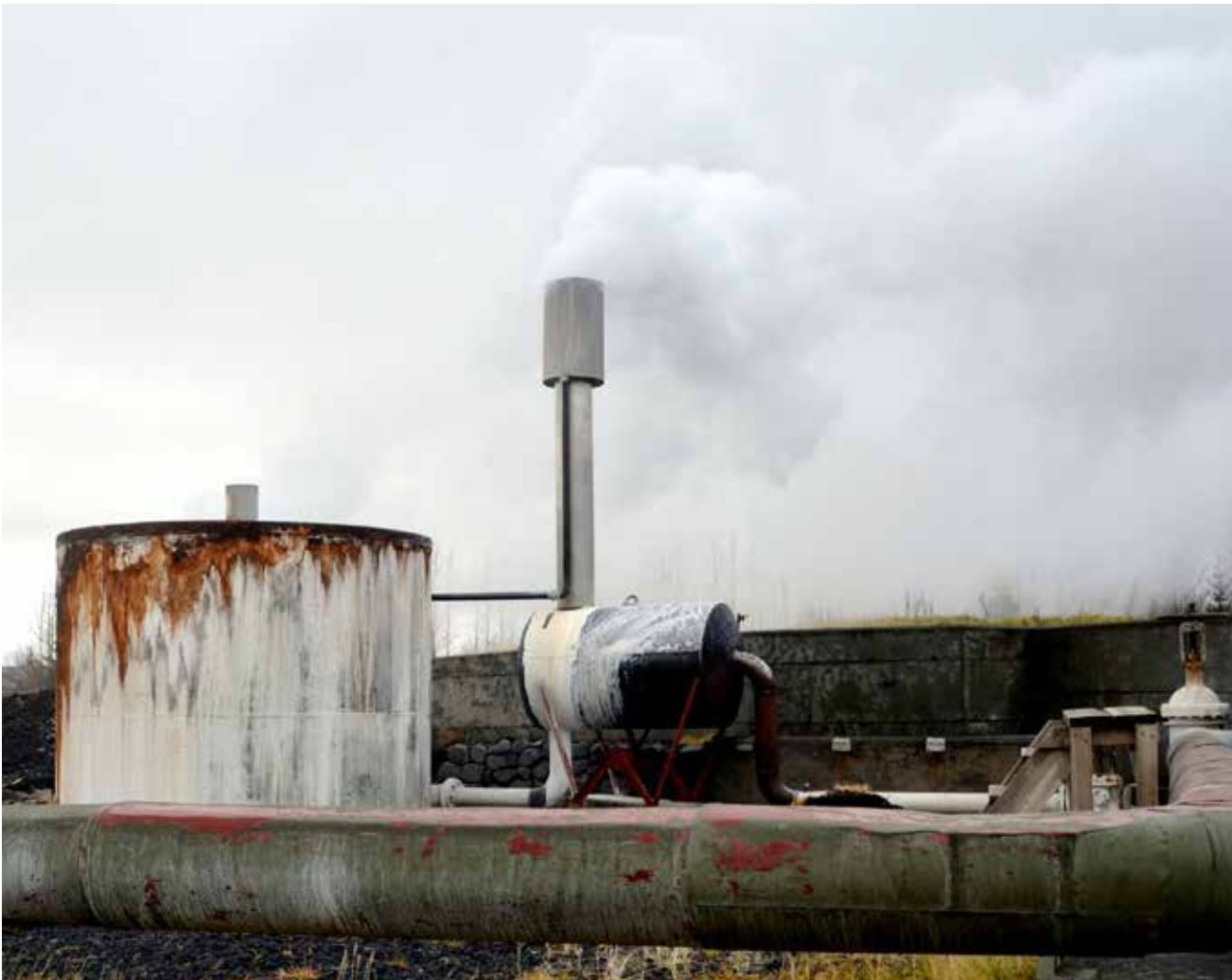
Mynd 37. Hljóðdeyfir og gufuháfur í Hveragerði. Ljósmynd: Bjarni Lindal.
