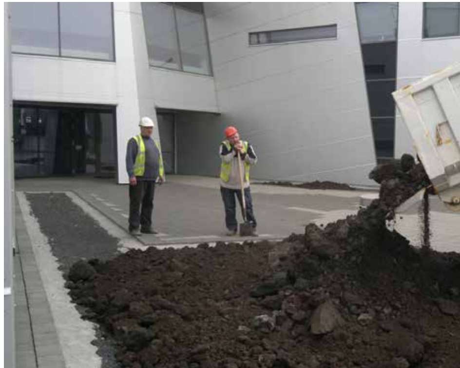
Mynd 35. Mosi og gjall af Hellsheiði nýtt í frágang við inngang að Hellsheiðarvirkjun. Ljósmyndir: Magnea Magnúsdóttir.
