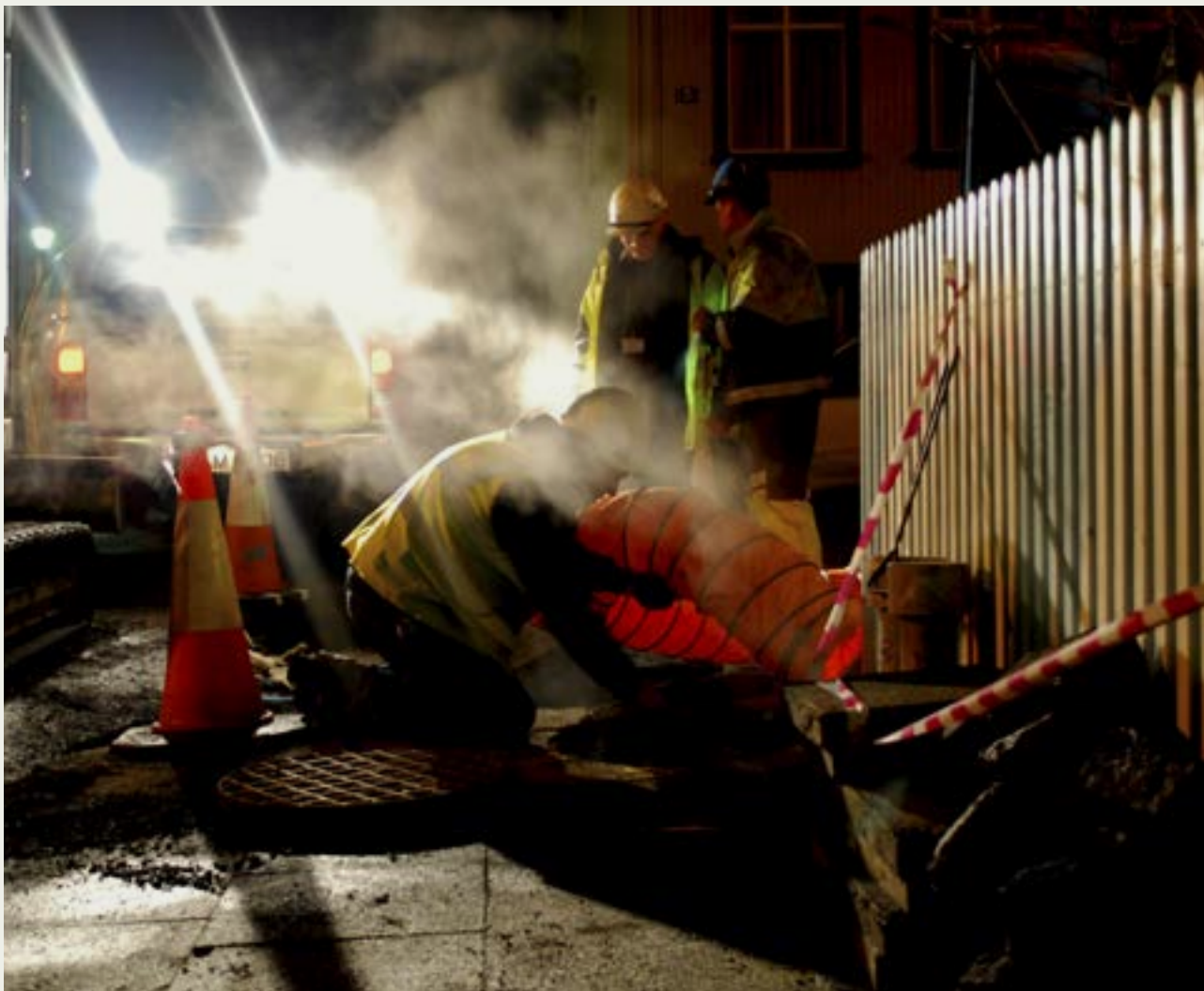
Mynd 11. Unnið að viðgerð á hitaveitulögn.
