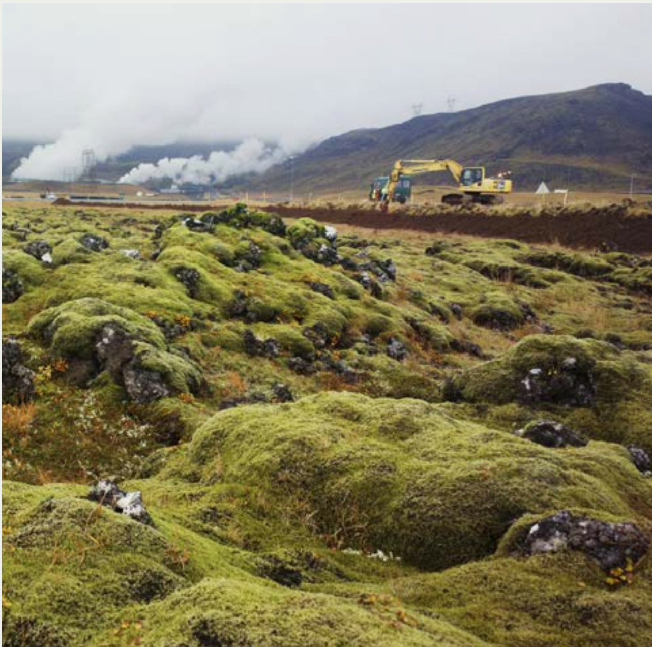
Mynd 6. Við byggingu gashreinsistöðvar á Hellisheiði á haustdögum 2013 var hluti af lagnaleið færður úr óröskuðu hrauni í raskað land í vegkanti. Ljósmynd: Magma Magnúsdóttir.
