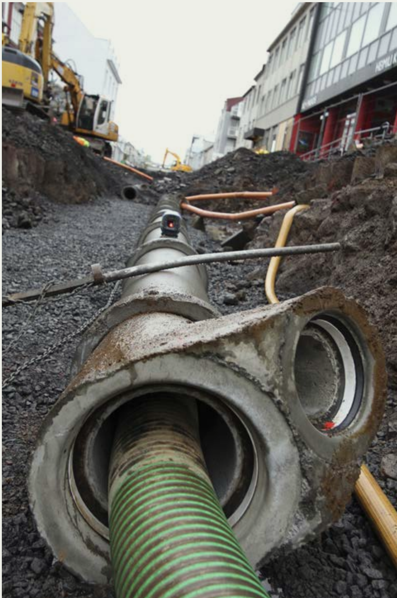
Mynd 14. Endurnýjun lagna í Hverfisgötu.
