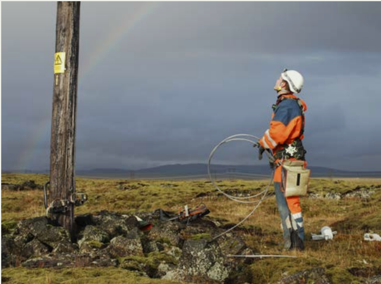
Mynd 1. Unnið að viðhaldi á raflínu.
