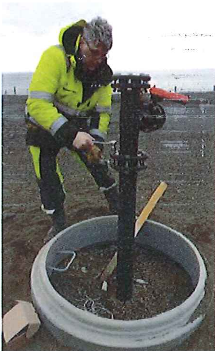
MYND 5 Endanlegir holutoppar með loka festir á borholu 3. Ljósmynd AK.
