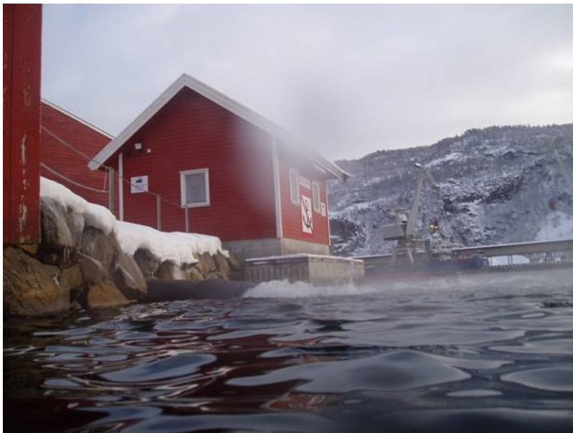
Figur 1 Bilde av utslippet. To utløp munner ut i fyllingen på 11 meters dyp, under overflateutslippet.
